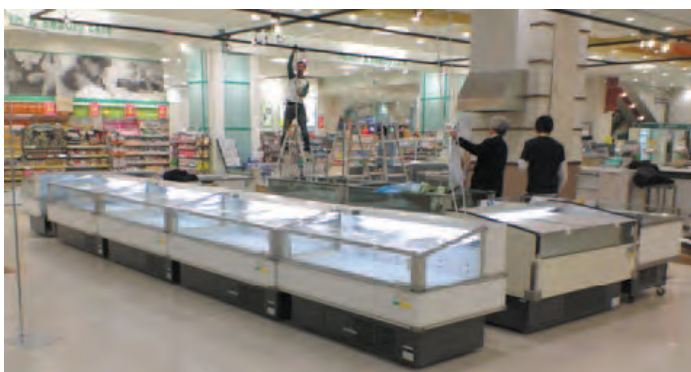
現場施工風景
